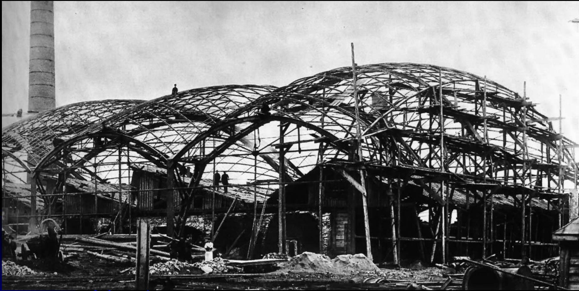
Строительство первых в мире оболочек-покрытий двойкой кривизны конструкции В.Г. Шухова (металлургический завод 1897 г.)
